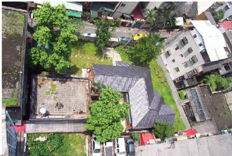
基地俯瞰照片
