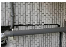
外牆柱斷裂
