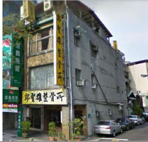
背(側)向立面照片
