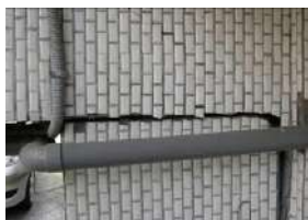
外牆柱斷裂
