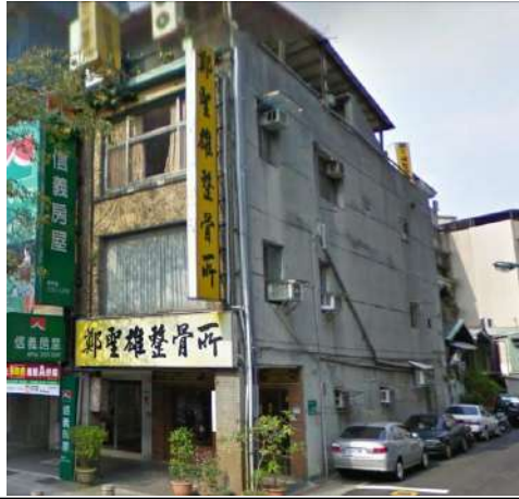
背（側）向立面照片
