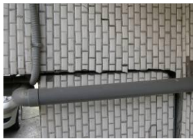
外牆柱斷裂
