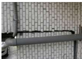
外牆柱斷裂
